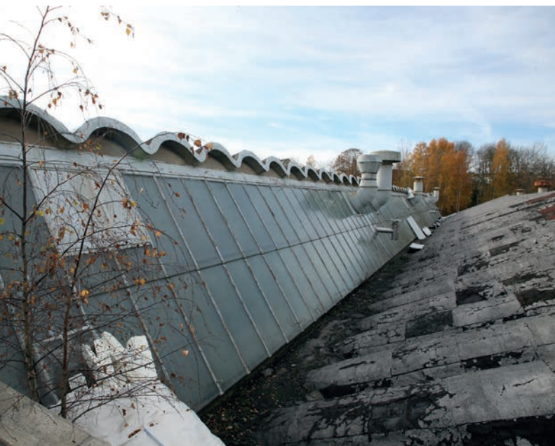
Rekonstrukce objektu Kannegiesser Bad Schlema
